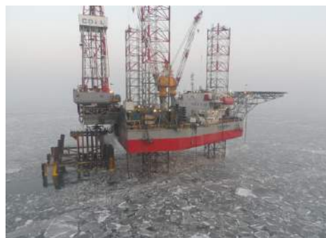
图2 渤海冰区自升式海洋平台
